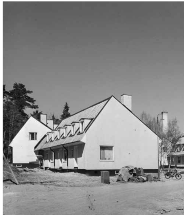
Söndagsvägen 76 (bilden är beskuren)
